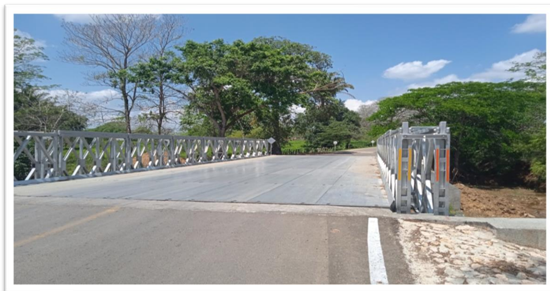
Imagen 31. Construcción de puentes en el municipio de Arjona en la vía que comunica al municipio de Arjona con el municipio de San
