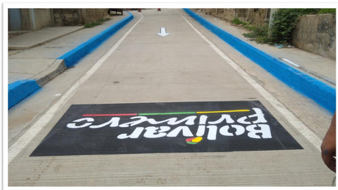
Imagen 29. Mejoramiento de la calle 24 desde la carrera 63 hasta la carrera 37 en el municipio de el Carmen de bolívar
