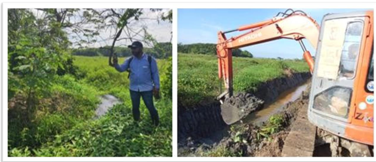
Imágenes 58 y 59 Estado inicial y trabajos de dragado y limpiezas en las AIE Calamar y Arroyohondo.
