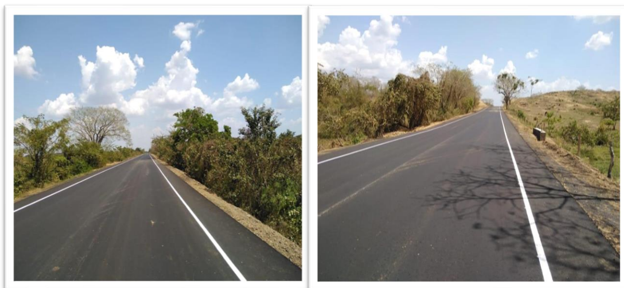
Imagen 25 y 26. Mejoramiento en concreto asfaltico de la vía que conduce del municipio de Arroyo Hondo a la intersección con la ruta nacional 25 en el Municipio de Calamar, del Departamento de Bolívar
