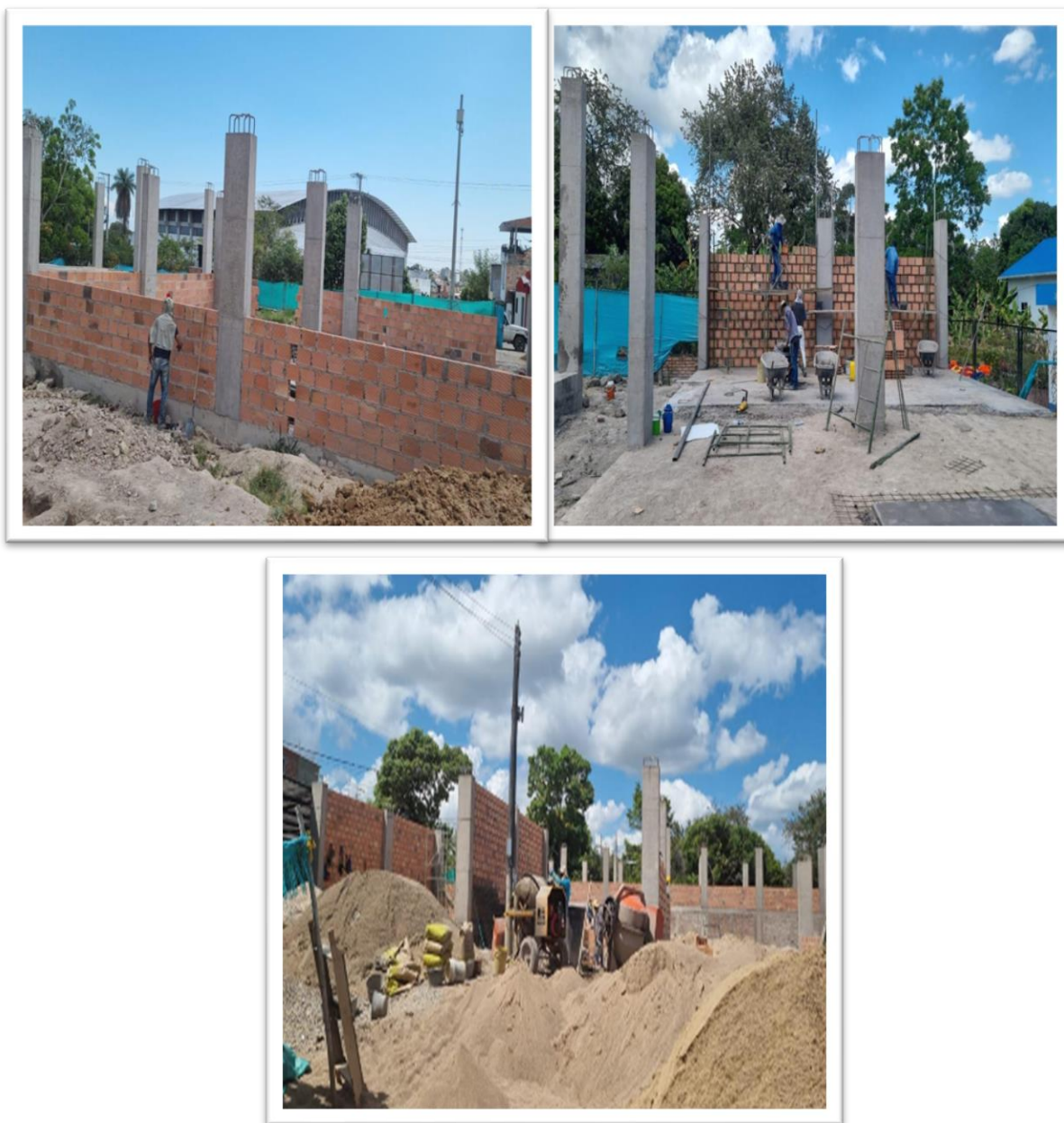
Imagen 37-39. Evidencias fotográficas de la construcción de un centro de formación y desarrollo minero en el municipio de santa rosa del sur, bolívar.
