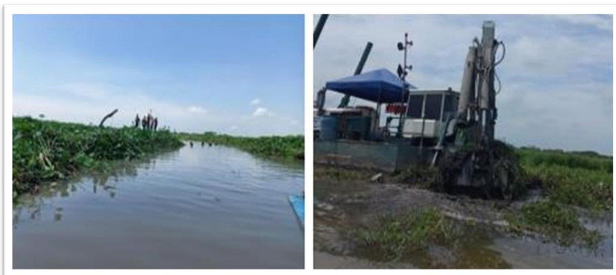
Imagen 56 y 57: Trabajos de excavación con maquina en lecho de la Ciénaga el Zarzal de Mahates
