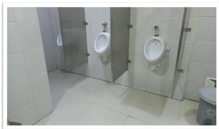
Imágenes 281-283- Mantenimiento baños CAD
