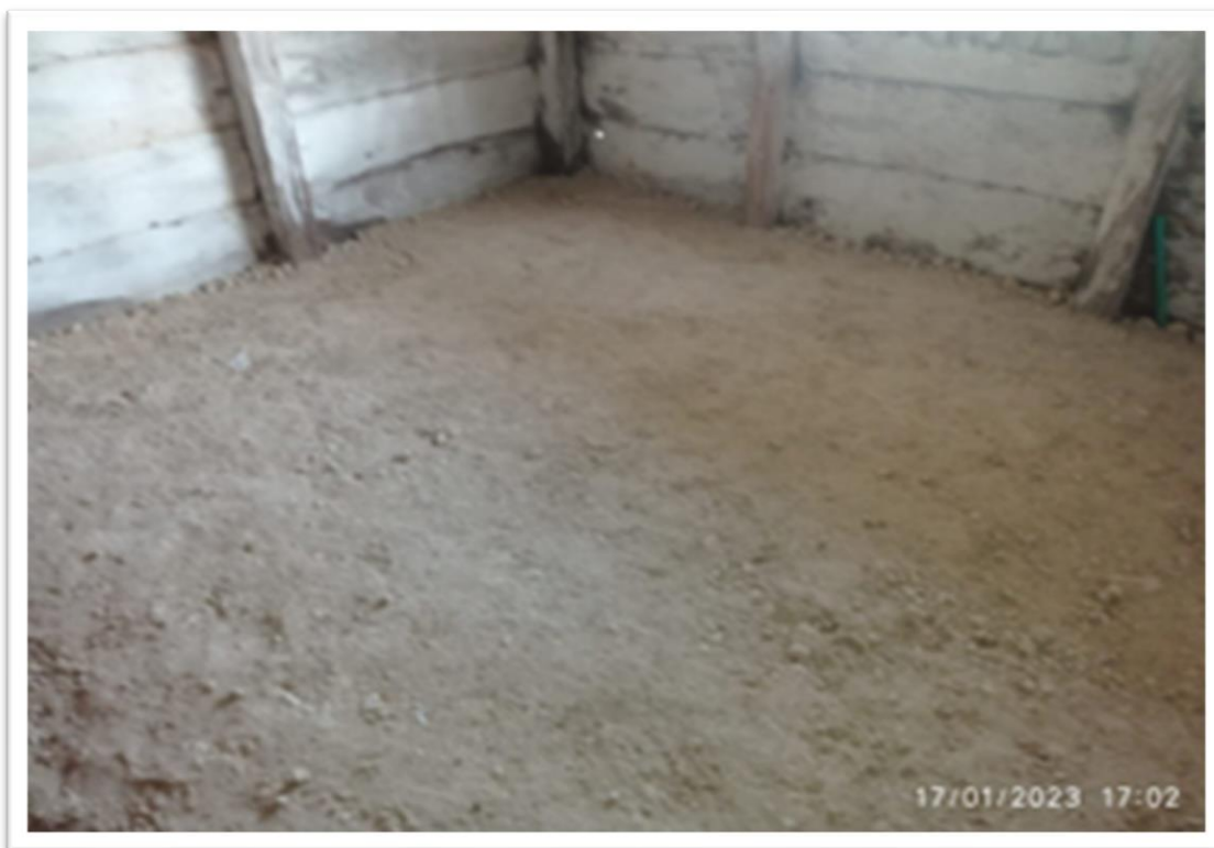
Imagen 135 Evidencia después de la intervención
