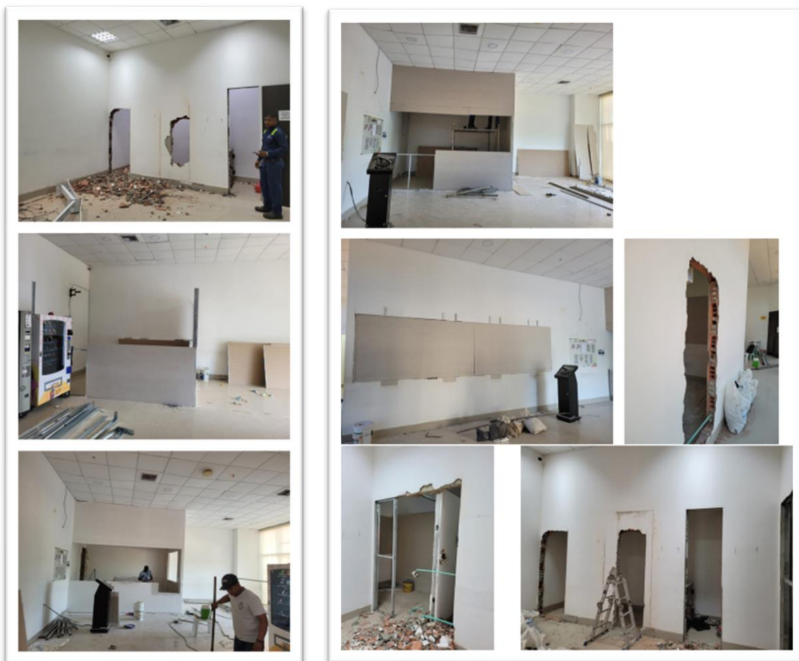
Imágenes . 361-380. Mantenimiento y adecuaciones locativas. Fuente. Elaboración propia. Dirección Administrativa de Logística
