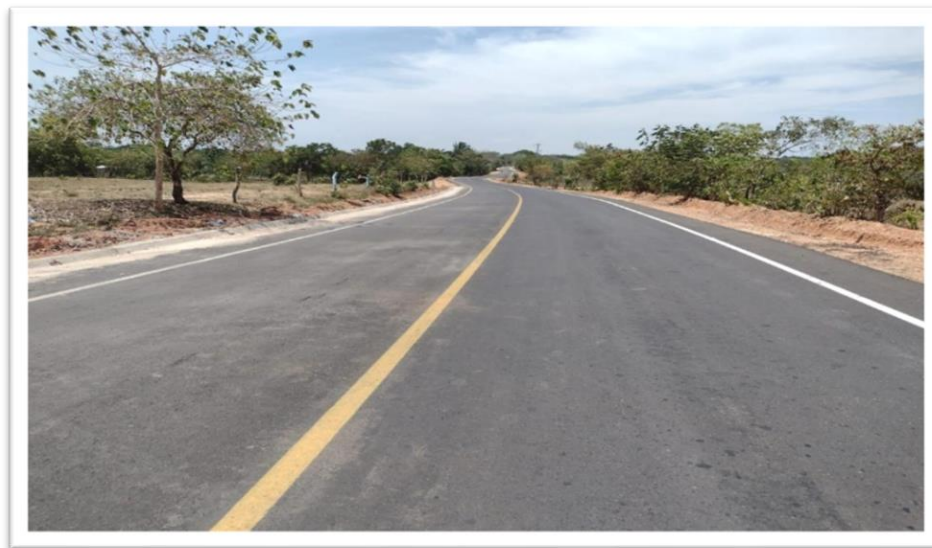
Imagen 390– Mejoramiento en concreto asfáltico de la vía que conduce al Municipio de Magangué
