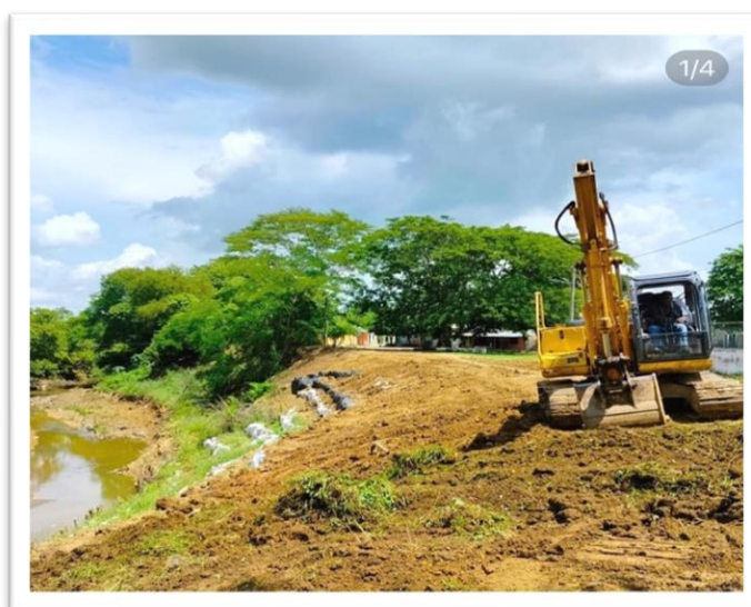
Imagen 129, 130 y 131 . Evidencia trabajo de maquinaria
