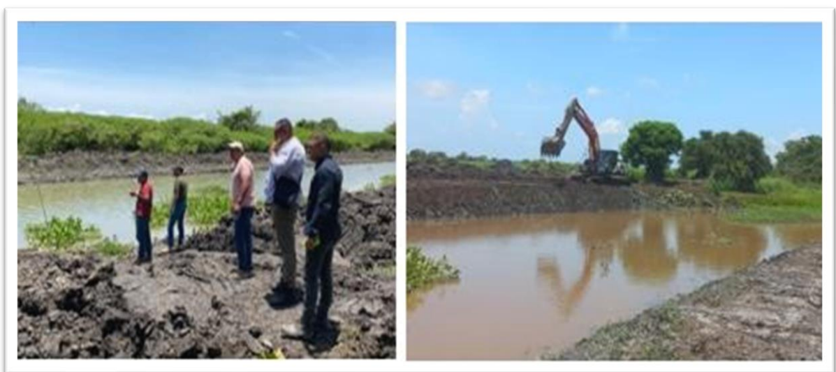
Imágenes 62 y 63. Trabajos de dragado y limpiezas en las AIE Magangué y Pinillos trabajos magangué pinillos
