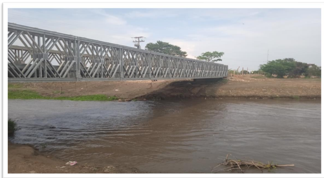
Imagen 32. Construcción de puentes por la Paz II, municipios de Mahates, el Guamo, Calamar, Barranco de Loba, Margarita y Magangué
