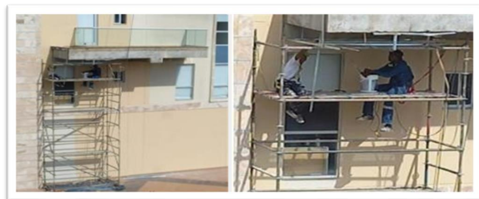
Imágenes 261-264 . Reparación baldosas levantadas CAD
