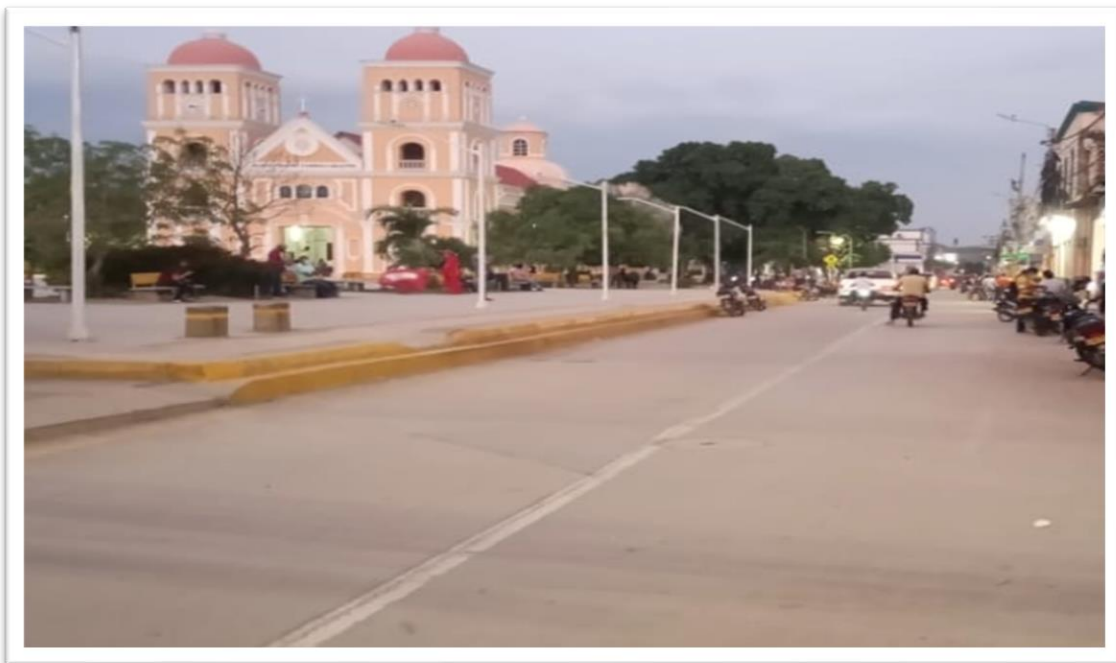
Imagen 28. Mejoramiento de la calle 24 desde la carrera 63 hasta la carrera 37 en el municipio de el Carmen de bolívar
