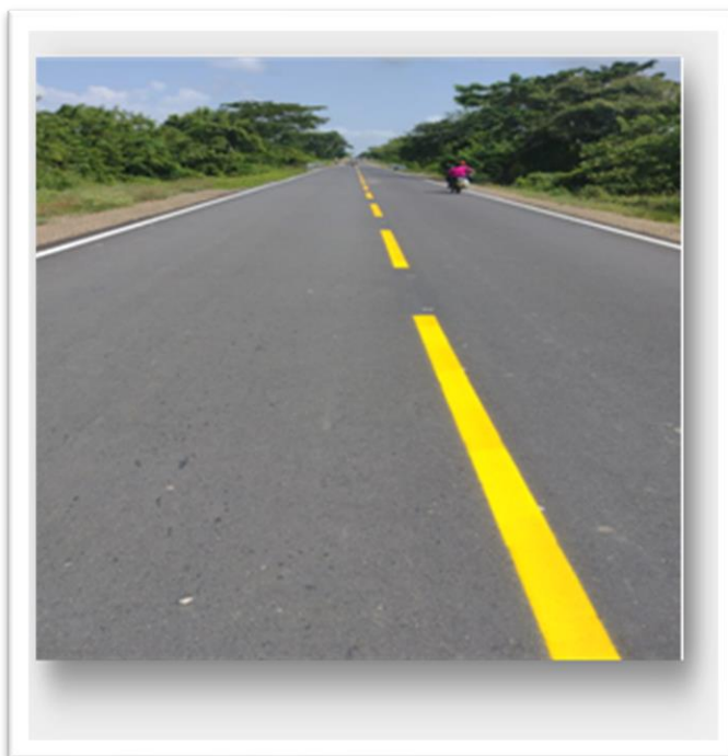
Imagen 27 Rehabilitación de la vía que comunica, el municipio de Mahates con la intersección - ruta nacional 25bl02 Carreto- Cruz del Viso en el Departamento de Bolívar
