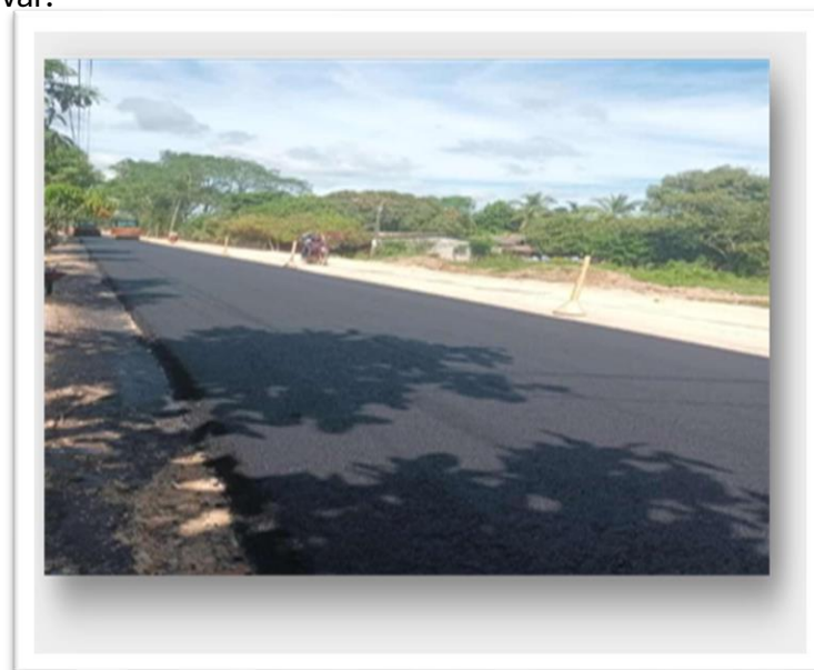
Imagen 391– Mejoramiento en concreto asfáltico de la vía que comunica al municipio de hatillo de loba con el corregimiento de botón de Leiva
