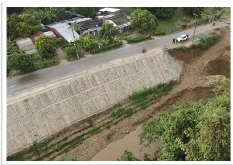
Imagen 84,85,86 Registro fotográfico antes y después de actividades ejecutadas
